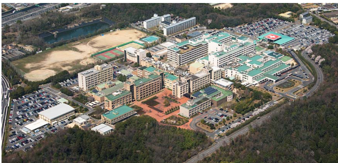
滋賀医科大学周辺写真(平成 26 年 4 月)
