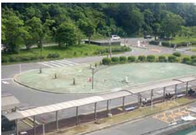
改修後の病院玄関前スペース
