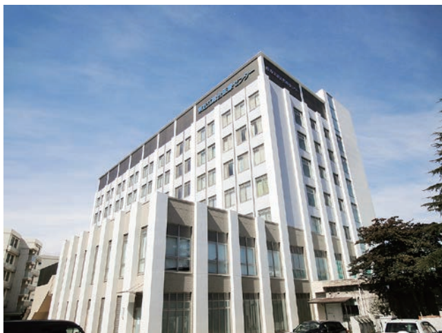
▲平成25年4月に竣工した新病棟
