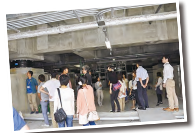
▲地下にある免電設備 見学の様子
