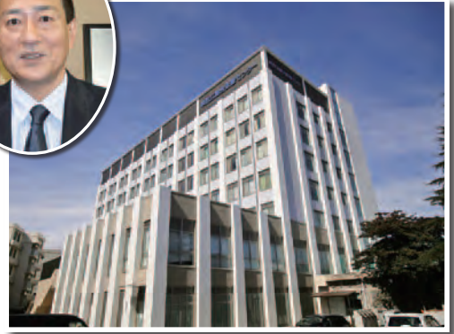
平成25年4月に竣工した新病棟
