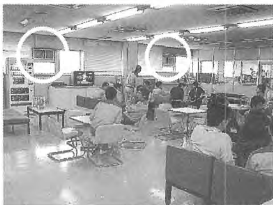
写真B4 厚生棟喫煙室 左：手前が喫煙室（窓の換気扇新設）、奥は禁煙休憩室 右：縮小された喫煙室（天井埋込型排気装置を2台増設）
