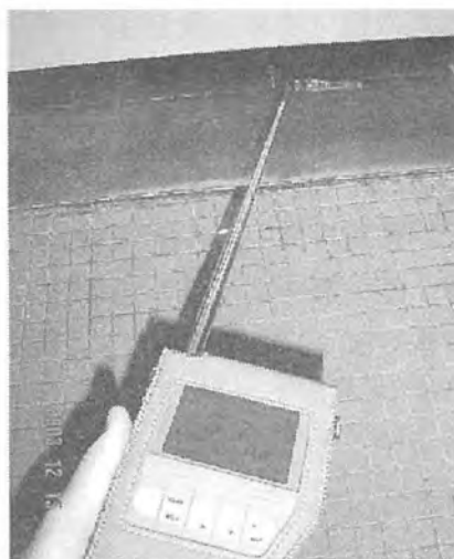
写真A 4. ドア下の隙間（幅 9cm） 風速 3.3～3.7m/秒
