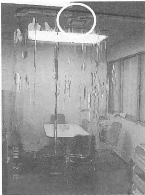
写真F 4 休憩室に設置された喫煙コーナー、内部には天井埋込型排気装置が2台
