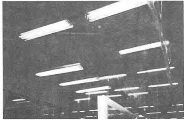
工業用の天井排気装置
