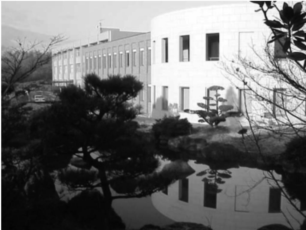
増築工事を終えたコラボレーションセンター
